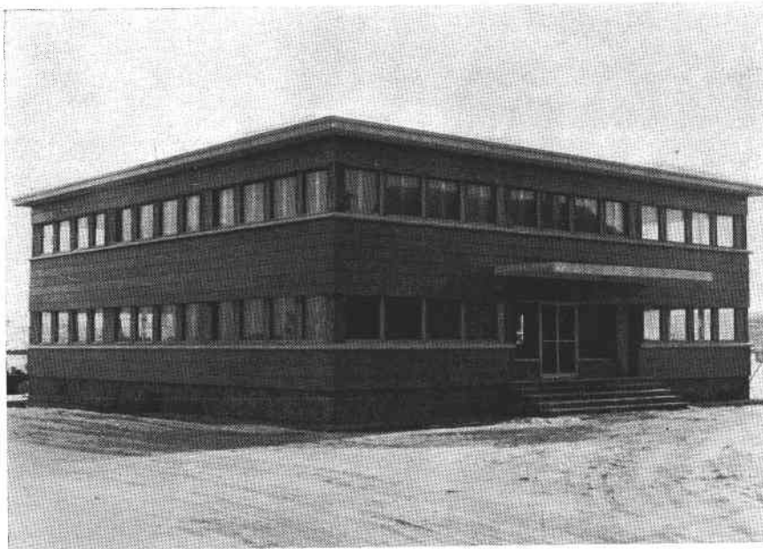
Vue générale du bâtiment.
